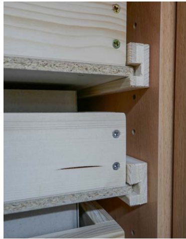
Abb. 3. Laden mit Schienen im Stecksystem. Die Schienen können auch kopfüber montiert werden, um die Abstände noch feiner zu regulieren.
