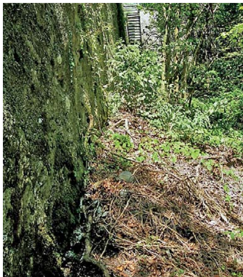
Abb. 1: Mauer am Kapuzinerberg.
