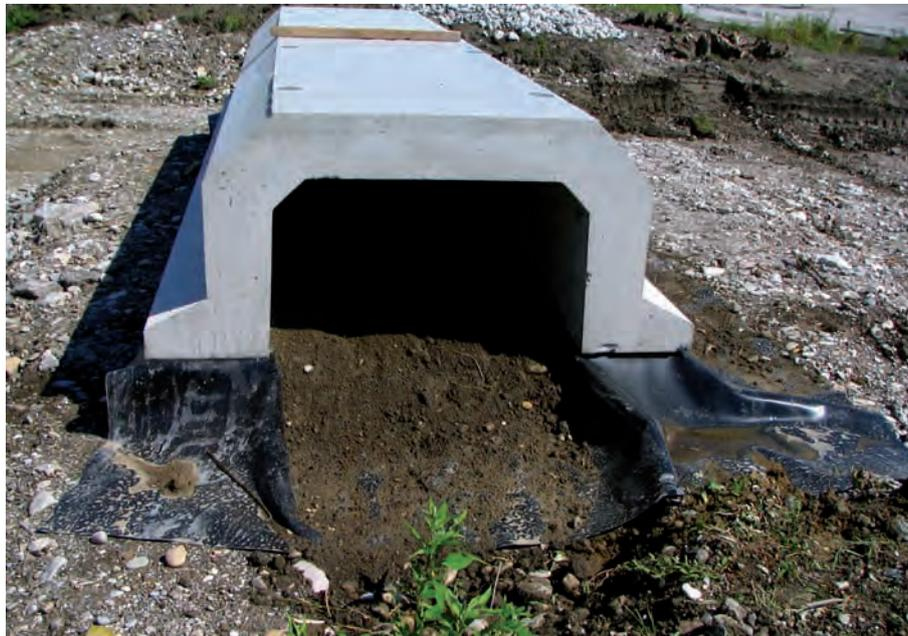
Abb. 6: Stelztunnel mit Foliendichtung (Foto: M. KYEK)
