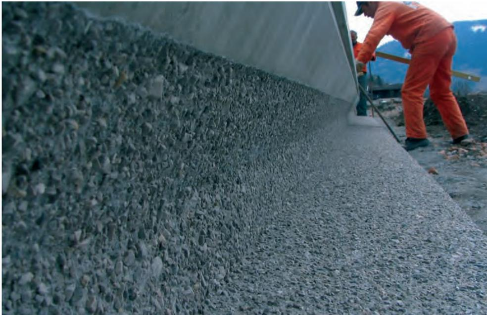
Abb. 4: Leitelement aus der "Froschperspektive" - Lauffläche und Leitwand sind aus Waschbeton, der Überhang ist mit einem zusätzlichen Überstiegsschutz versehen (FOTO: M. KYEK)
