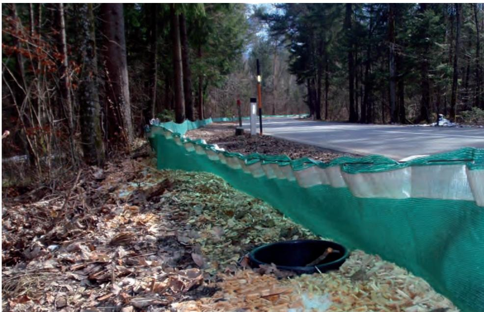
Abb. 2: Beispiel eines mit Spannschnur errichteten und mit Hackeschnitzeln hinterfüllten Schutzzaunes (L114 Großgmainer Landesstraße). Derartige Zäune sind im Land Salzburg seit ca. 20 Jahren im Einsatz (Foto: M. KYEK)
